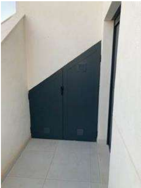
IMAGEN 9.11: CERRAMIENTOS PARA ALMACENAMIENTO (PERMANENTES)
