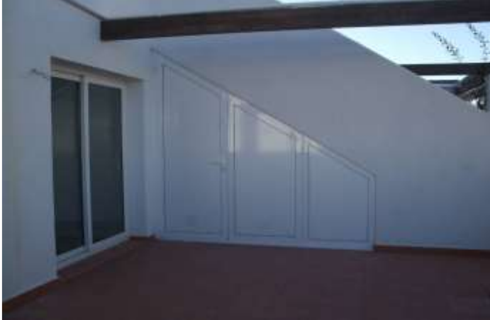
IMAGEN 5.5A: ALMACENAMIENTO DEBAJO DE ESCALERAS
