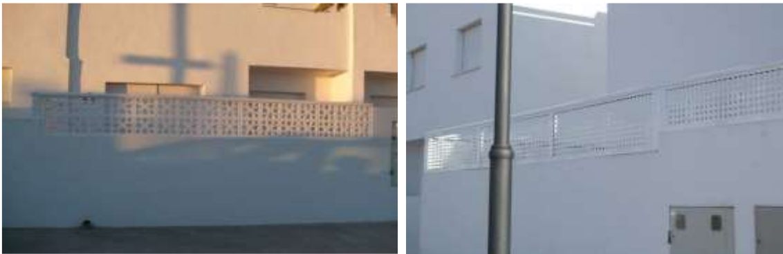
IMAGEN 4.8: PAREDES EXTERNAS Y CELOSÍAS
